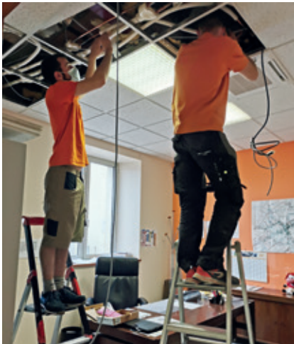
Mai 2021 • Installation de la climatisation en Mairie
